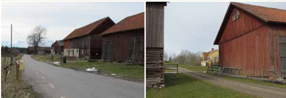
Storskifteskarta över Torwalla från år 1770 visar radbyn belägen norr om bygatan. Torwalla by som är en till strukturen välbevarad radby med bebyggelsen samlad på ena sidan av bygatan. Boningshusen ligger skyddat från gatan bakom ekonomikomplexen. Byggnadsbeståndet är till stor del förnyat under 1800 och 1900-talen.
