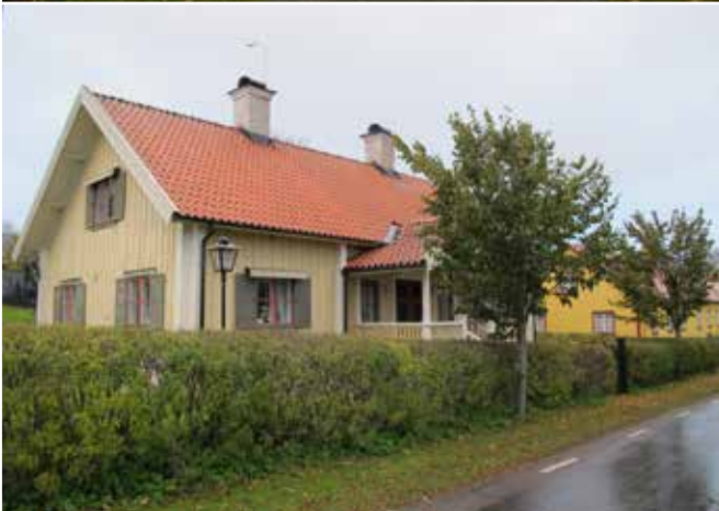
Längs med huvudinfarten till bruket, nuvarande Brobyvägen, kantas ena sidan av äldre arbetarbostäder bland annat för brukets lärare och läkare. Byggnaden ifråga härrör troligtvis från 1700-talets andra hälft och blev bostad för brukets veterinärer från 1842 och framåt.
