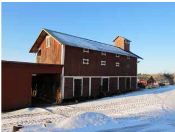
Magasinet väster om huvudbyggnaden består av en gradvis utbyggd timmerbod.
