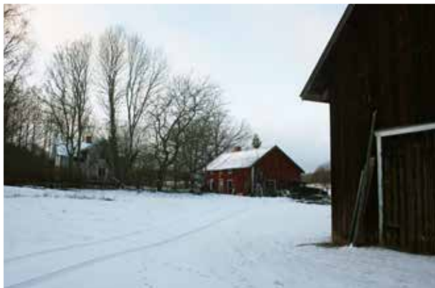
Gården Stentorp med boningshuset i fonden.
