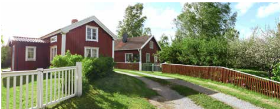
Norrgården utgör en sammanhållen gårdsmiljö med välbevarat byggnadsbestånd och gårdsbild.
