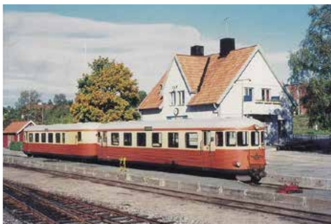
Hallstaviks järnvägsstation som stod klar 1915 syns här 1966, samma år som persontrafiken till orten lades ner.
