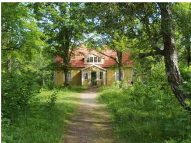
Solvik på Granö är en typisk barnkolonibyggnad från omkring år 1920. Byggnaderna förekommer både med brutet tak och sadeltak. Ofta har byggnaderna fönsterkuper, veranda och burspråk för att få in så mycket ljus som möjligt. De småspröjsade fönstren är vanligt förekommande även om de bytts ut på flera hus.
