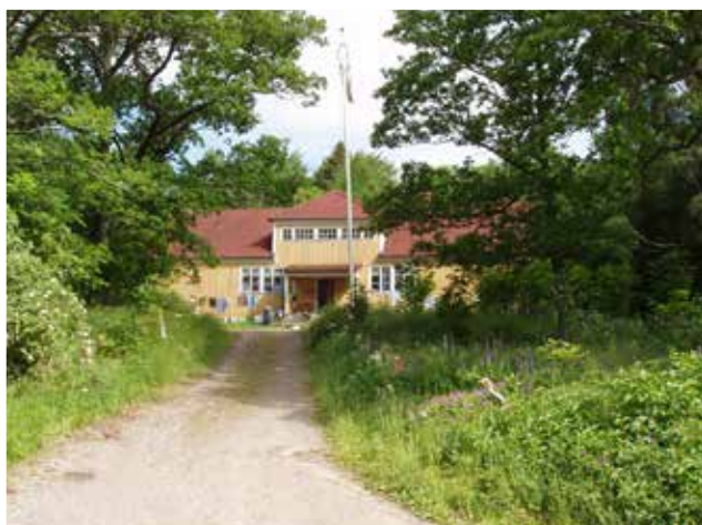
Vid Vretarna finns även gården Backvreten som tillhör de första byggnaderna som uppfördes för barnkoloniverksamheter år 1911.
