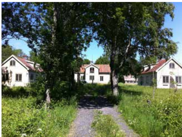
Sundsro barnkoloni har en grunden äldre huvudbyggnad kompletterad med logement 1920. En trädkantad grusväg leder fram till gårdsplanen. I logementen märks 1910-talets formspråk i form av sadeltak med nätta fönsterkupor och småspröjsade fönster.
