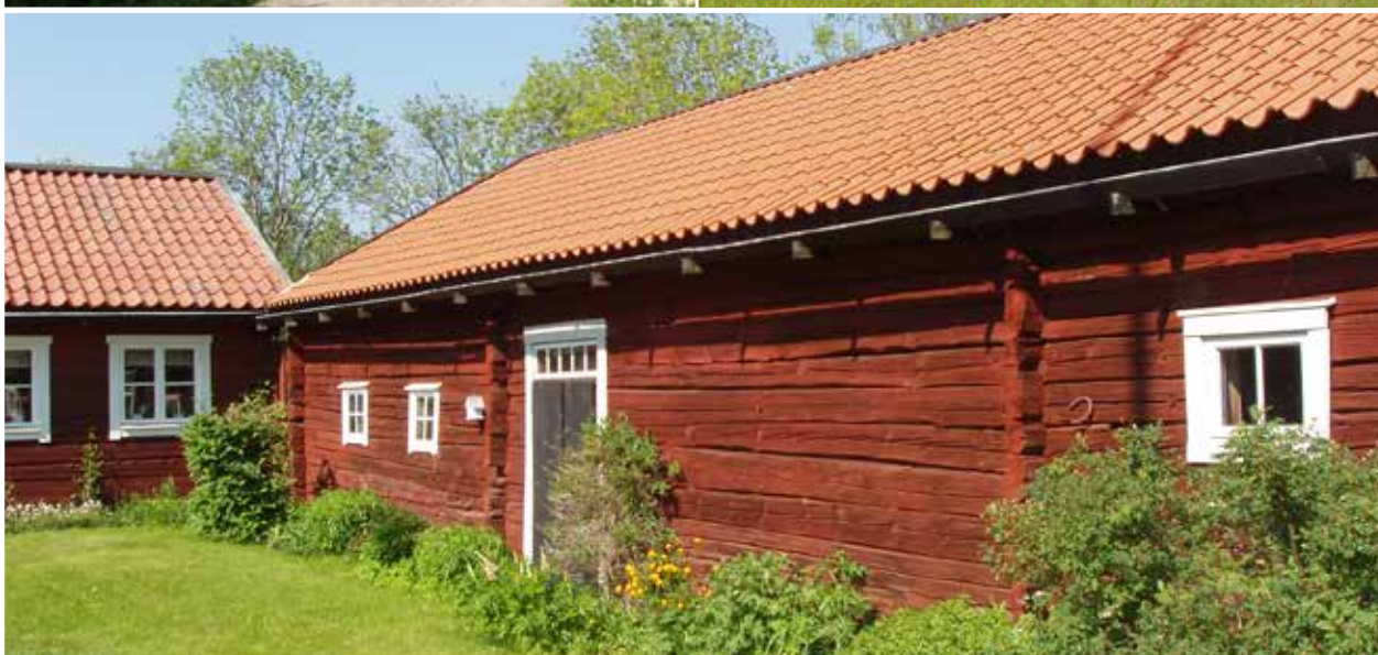
Westerbergs gård är en av de äldsta mest orörda miljöerna i byn. De tidigare ekonomibyggnaderna är typiska för tiden. Huvudbyggnaden som ligger strax till vänster om dessa byggnader är en parstuga och representerar storleken på bostadshusen innan redarnäringen satte spår i bebyggelsens utformning. Bykärnan dominerades då av parstugor liknande denna.
