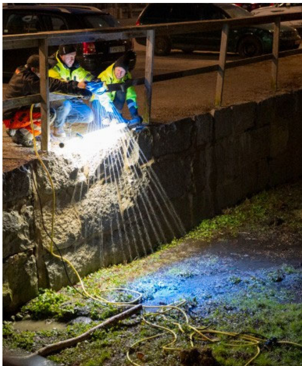
Vid en provbelysning testar man olika alternativ och upplever hur den färdiga ljussättningen kan komma att se ut. Provbelysning vid Kvarngårdsparkeringen, Norrtälje.
