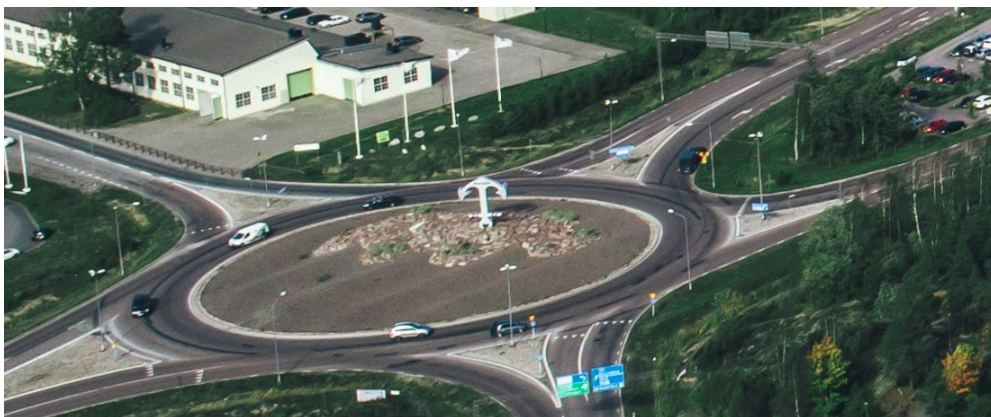
Cirkulationsplats vid Södra infartan: Exempel på befintlig korsning som saknar tillgänglighet för gående. I sin tur skapar avsaknaden av tillgänglighet en låg korsningstäthet och barriäreffekter mellan stadsdelar.
