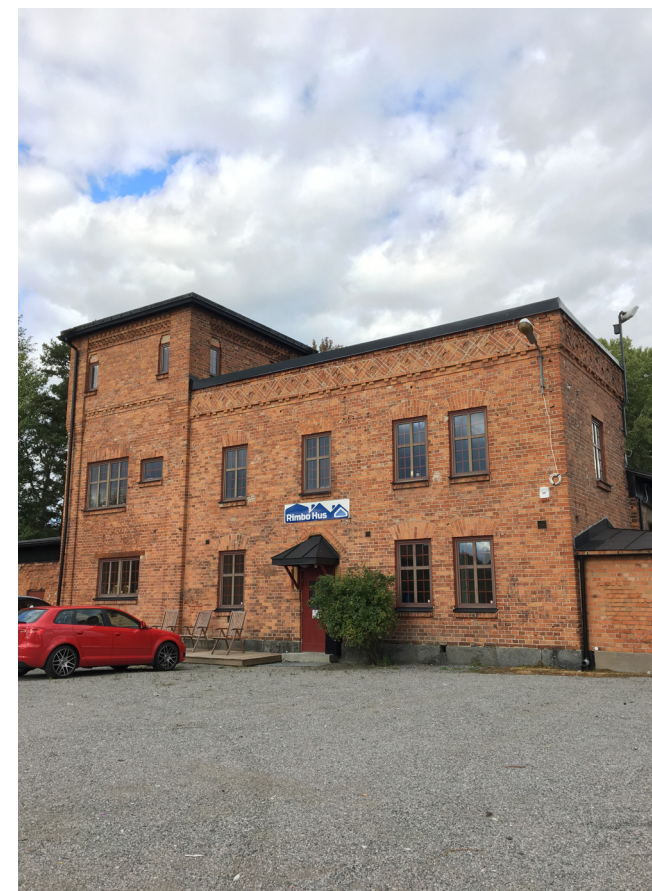
Tegelbyggnad tillhörande loksallanläggningen. I tornet fanns tidigare badhus.
