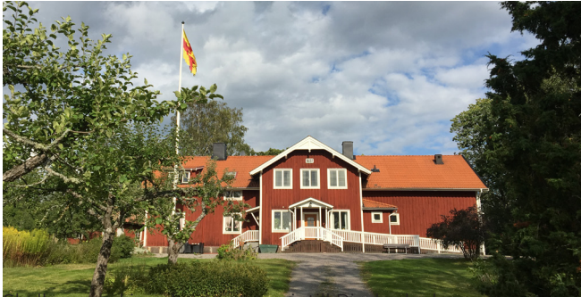
Skolbyggnad i sockencentrum intill Rimbo kyrka.
