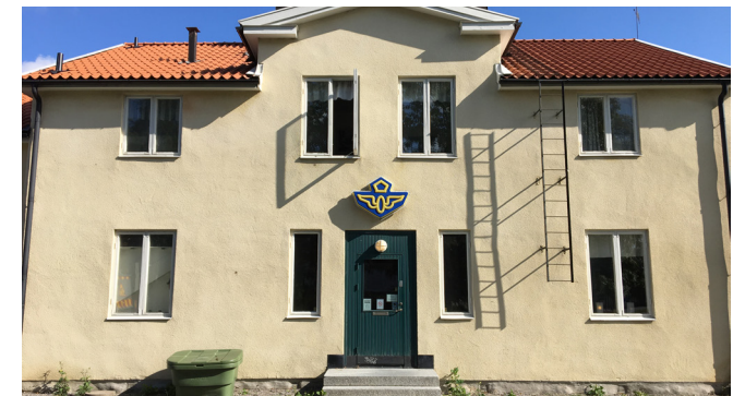
Rimbo stationshus har genomgått många förändringar under 1900-talet.
