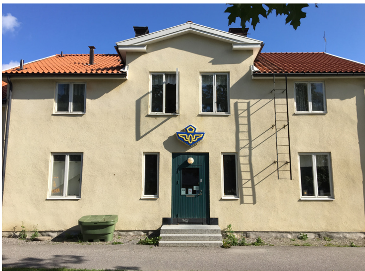
4 Stationshuset i Rimbo är ändrat i flera omgångar men har ett mycket högt kulturhistoriskt värde eftersom det utgjort en av de mer viktiga byggnaderna i stationssamhället Rimbo.
