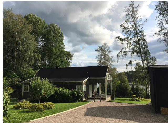
Fritidshus ombyggt till permanentboende, Midsjö.
