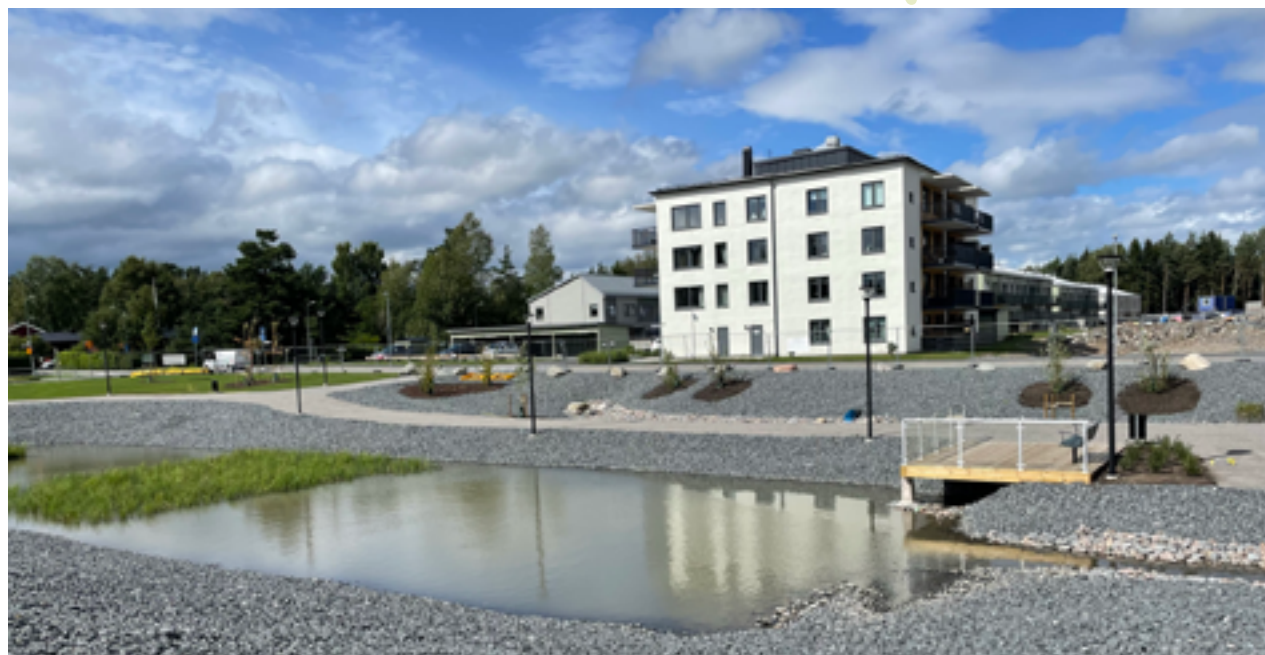
Dagvattenanläggning i Bålbroskogen
