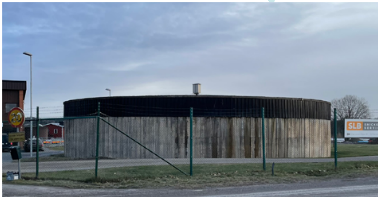
Rimbo allmänna reningsverk i östra delen av Rimbo. Reningsverket ger ifrån sig lukt i centrum vilket i dagsläget medför hinder för utvecklingen.
