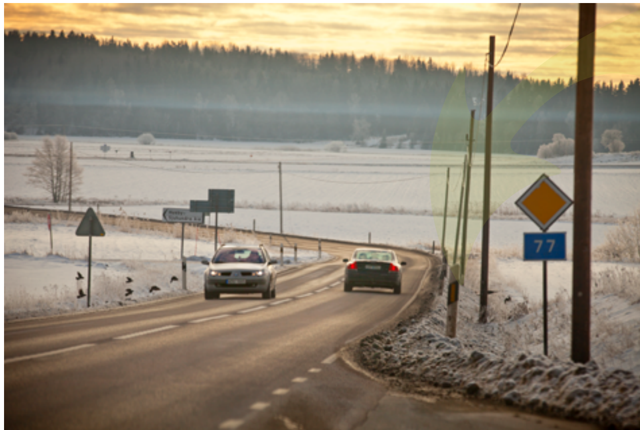
Trafiken på väg 77 genererar både buller, vibrationer och luftföroreningar.
