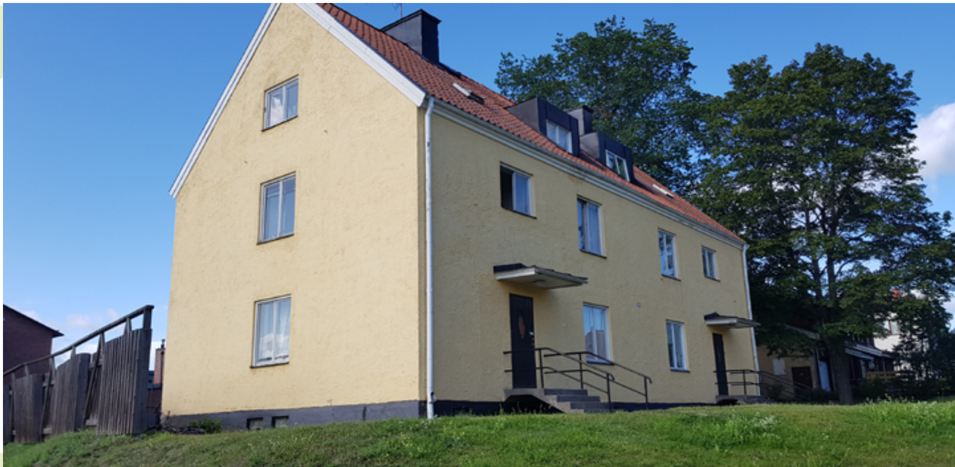
Fastigheten Sperlingen 1. Kring 1900-talets mitt uppfördes flertalet flerbostadshus i Rimbo, flera av dem är väl underhållna och några har många bevarade originalbyggnadsdelar. De välbevarade flerbostadshusen visar på den stora expansion och utveckling Rimbo hade kring 1900-talets mitt. Från kulturmiljöutredning, WSP, 2019.
