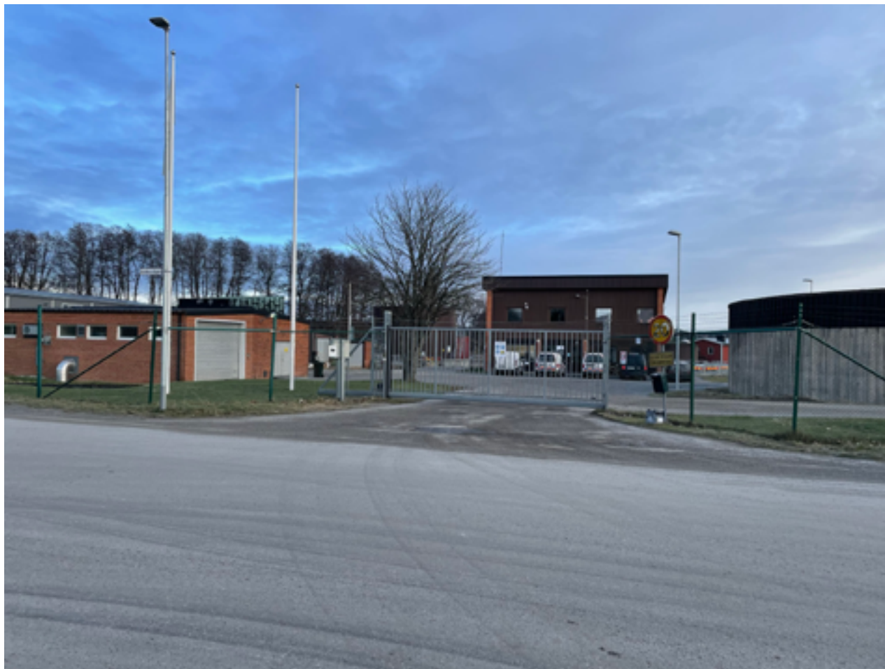
Rimbo allmänna reningsverk.
