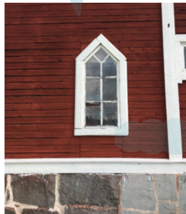
Fönster på ekonomibygnad i Adamsberg. Fönstret har Löfvenskiölds ritningar som förlaga. Foto: WSP, 2019.
