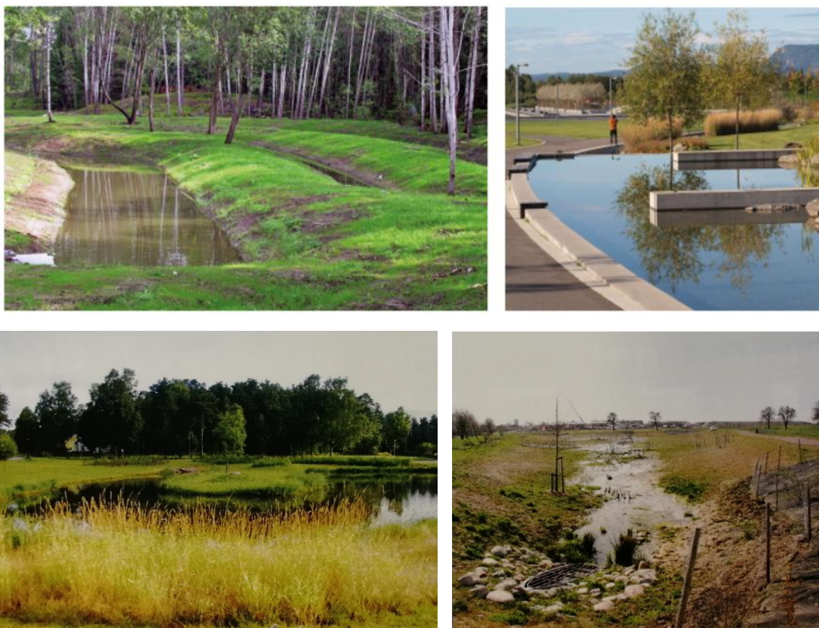
Figur 38. Exempel på öppna dagvattenlösningar i form av dagvattendammar i olika miljöer (Bildkälla: WRS, Svenskt Vatten).
