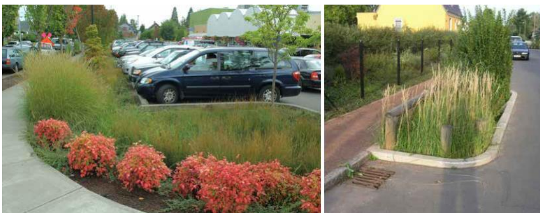
Figur 40. Exempel på nedsänkta växtbäddar i anslutning till allmän platsmark (Stockholm stad och WRS)
