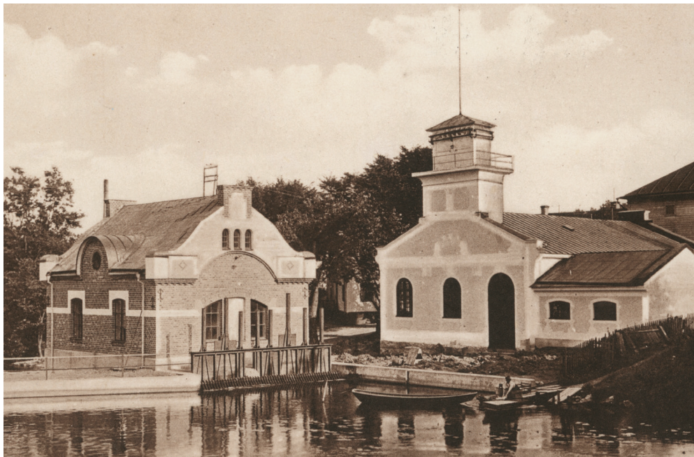
Elktricitetsverket vid Norrtäljeån. Foto från 1920-talet. Järnvägs museet.
