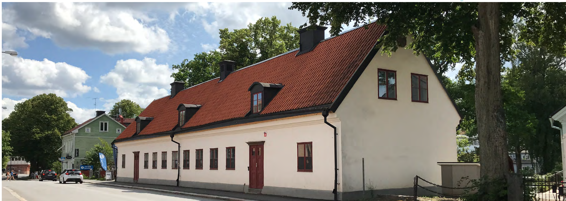
Före detta gevärsfaktoriet på fastigheten Faktoriet 1
