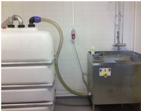
Figur 11: Fobox matavfallskvarn med sluten tank. Källa: Irec
