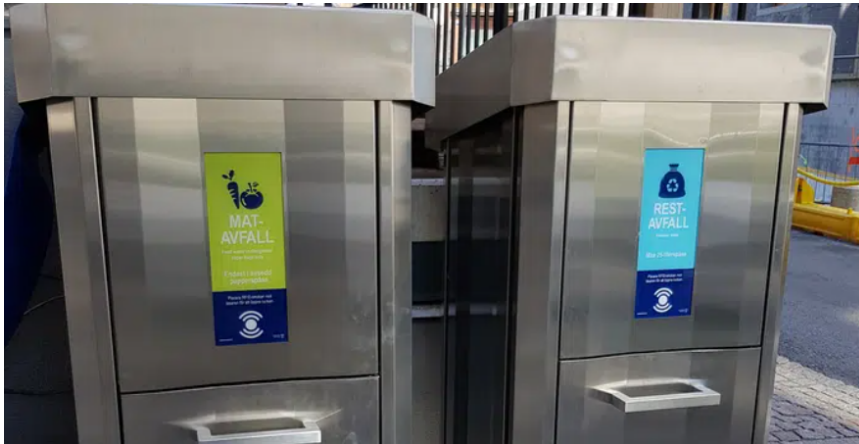
Figur 9 Inkast till sopsug i Norrtälje Hamn – mat i 9l papperspåse och rest isopspåse < 25 l.
