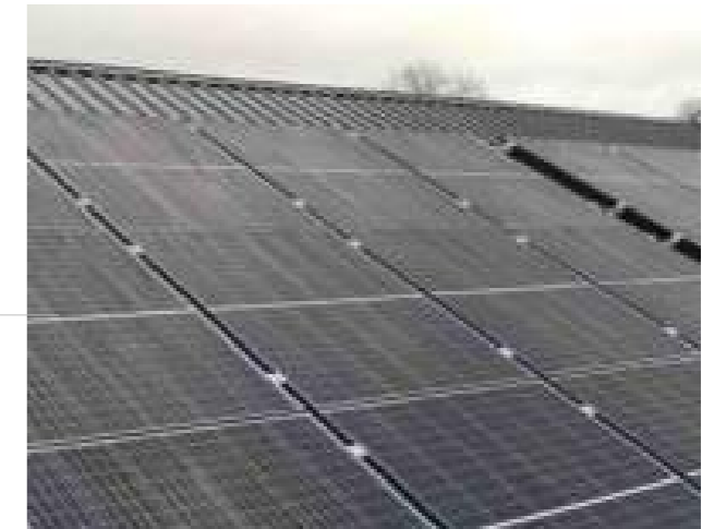
Solceller på plåttak
