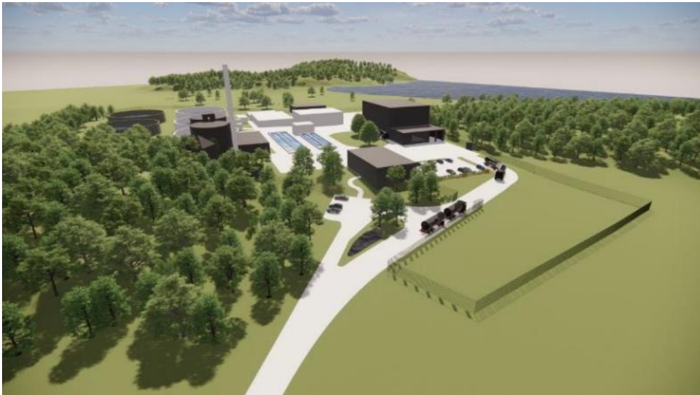
Figur 20: Vy från nordväst över reningsverket och angöringsväg (NVAA).
