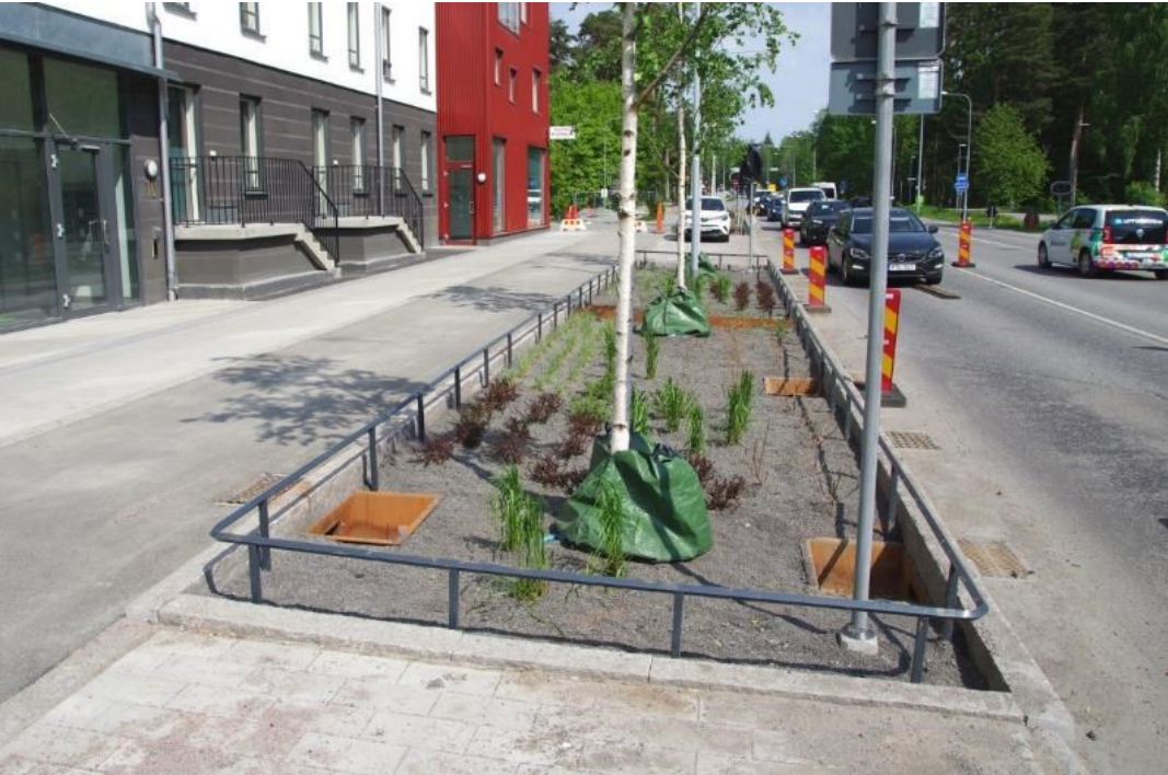
Figur 21. Nyanlagd regnbädd i Rosendal, Uppsala. Bädden ligger utmed Vårdsätravägen. Intag via brunnar (spygattbrunnar, alltså brunnar utan sandfång) och sedimentationskar. Foto: WRS.
