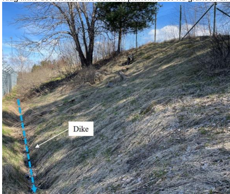
Figur 12 Befintligt dike vid norra gränsen till planområdet intill kommunens bussdepå, WRS (2024-04-23).
