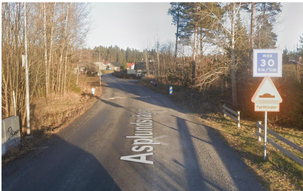
Bild 1. Farthinder och rekommenderad hastighetsskylt vid anslutningen till förskolan
