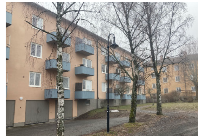
Flerbostadshus från 1940-talet. Utskjutande takutsprång, sadeltak, tvålufts-fönster och små balkonger med front i plåt. Inbyggda garage vittnar om bilismens intåg.
