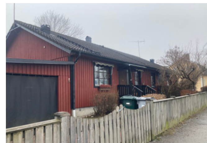
Villa norr om ån uppförd under 1960-talet. Byggnaden har ett horisontellt uttryck. Den har sadeltak och fasader klädda i träpanel.
