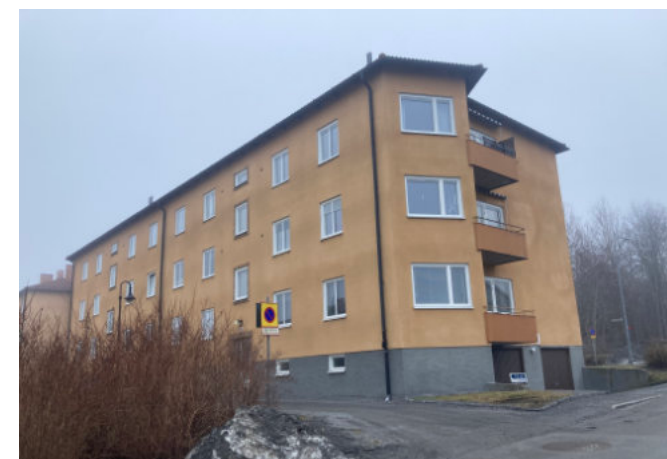
Flerbostadshus med uppbruten och vinklad gavel. Stora fönster på gaveln för gott ljusinsläpp. Byggnaden har ett flackt tak.
