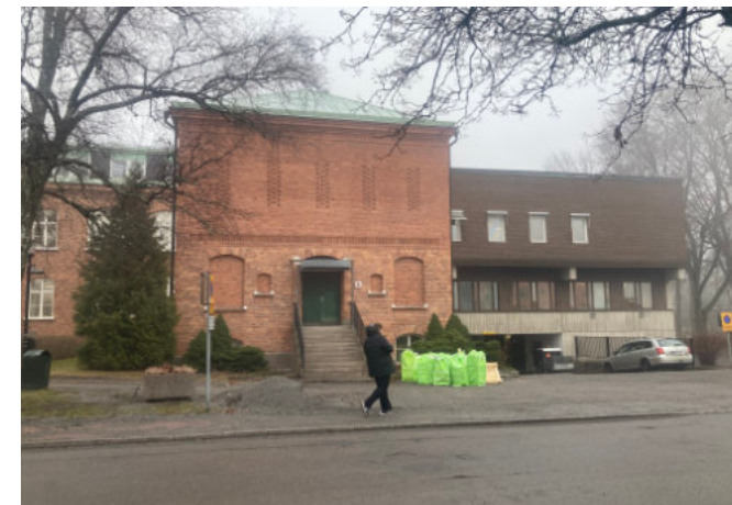
1960-talets tillbyggnad flankerar lasarettets östra gavel. Ett avvikande tillägg med tidstypisk 1960-talsestetik som berättar om sjukhusets stora expansionsfas. T.v. i bild syns även lasarettets påbyggda vindsvåning.
