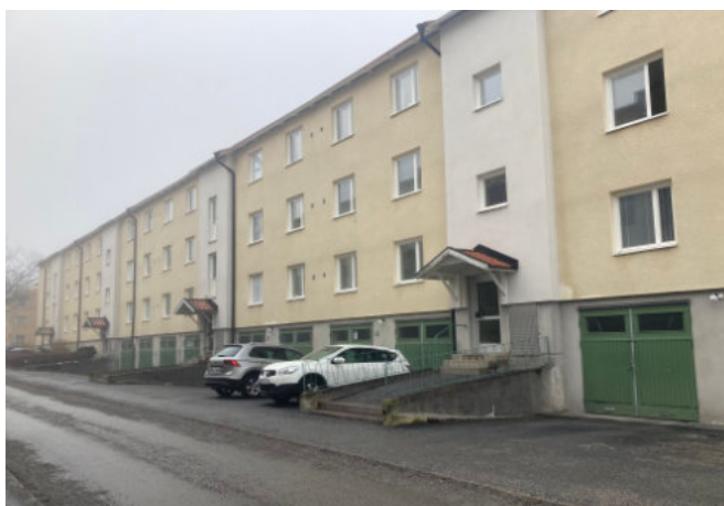
Flerbostadshus från 1950-talet. Byggnaden har ett uppbrutet fasadliv, större fönster med vädringslucka, flackt sadeltak, putsade fasader och inbyggda garage.
