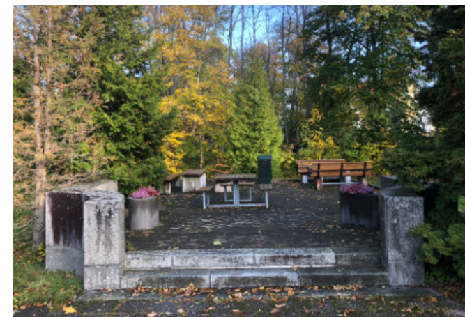
Terrass bakom sjukhusbyggnad. Terrassens inramning vid trappan bär klassicistisk prägel. Terrassen utgjorde den tidigare entrétrappan till överläkarbostaden men används idag som en terrass.
