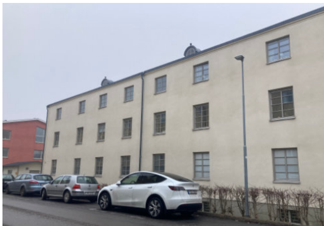
Flerbostadshus, från början uppfört åt sjukhusets anställda. Byggnaden har klassicistiska stildrag med profilerad takgesims och takkupor. Spröjsade fönster bidrar till ett ålderdomligt uttryck.
