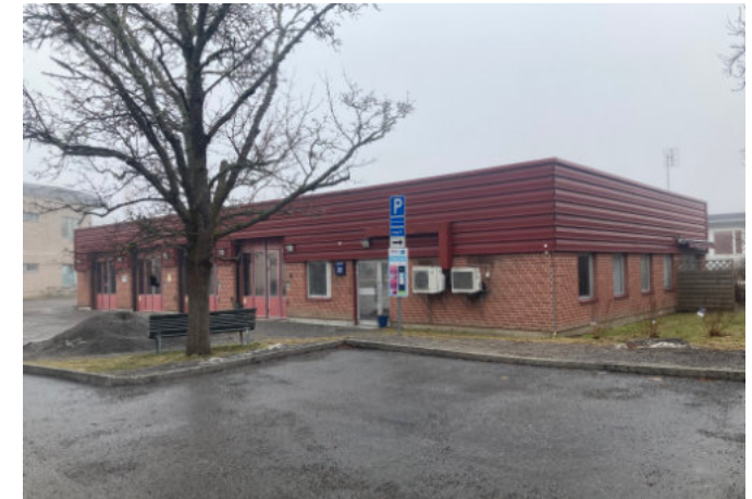
1980-talets byggnadsvolym är uppförd i tegel. Halva volymen utgörs av en taksarg i röd kulör. Byggnaden har stående enlufts-fönster. Garagedörrarna vittnar om funktionen som ambulansstation.
