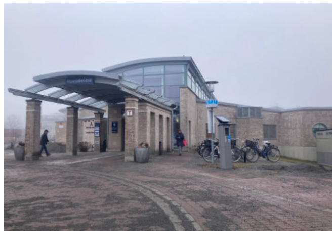
Entrén till 1990-talets sjukhusbyggnad med sitt stora skärmtak buret av kraftiga pelare och uppskjutande glasade del är bärande karaktärsdrag.
