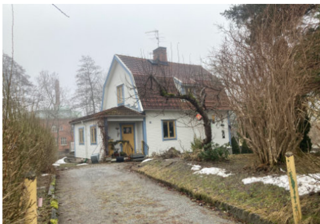
På norra sidan av ån finns flera äldre villor uppförda under 1900-talets första årtionden. Dessa har stensockel, brutna sadeltak och panelklädda fasader.
