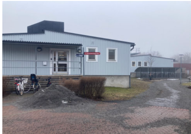
1970-talets paviljonger har en provisorisk karaktär. Byggnaden har flackt sadeltak och panelklädda fasader i ljusblå kulör.
