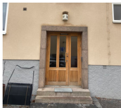
Ett diskret utformat modernistiskt entréparti med omfattning i natursten, porten något indragen.
