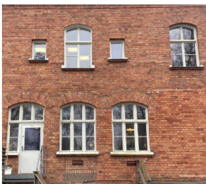
Den ursprungliga sjukhusbyggnaden med olika fönstertyper. Ofta stickbågi-ga och spröjsade med mönstermurade överstycken.
