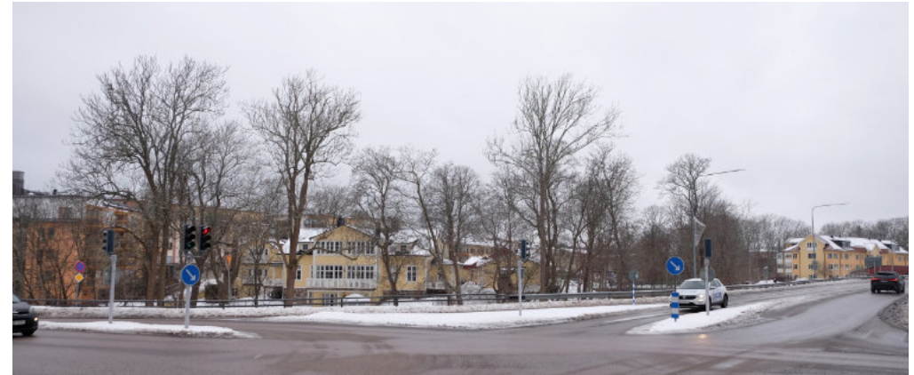
2. Vy från korsningen Stockholmsvägen/Estunavägen. Bakom trädriddån till höger den ursprungliga lasarettbyggnadens röda tegelfasader.
