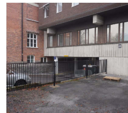
1960-talets tillbyggnad med tidstypisk prägel. Fasaden är klädd med formgjuten betong, inslag av träpanel och brunt tegel. Fönsterband.
