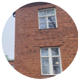
Korspostfönster med spröjs
