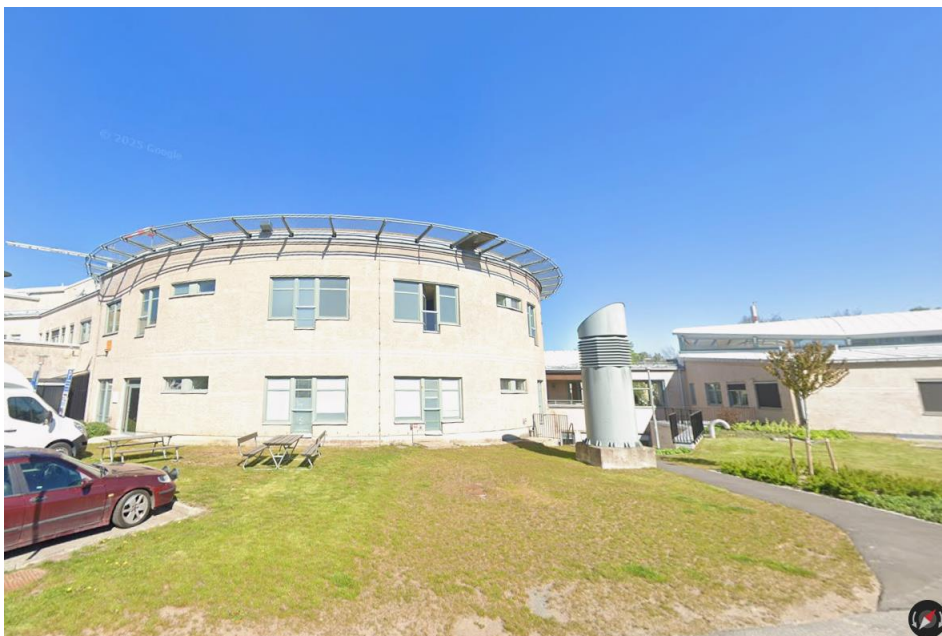
Figur 4. Befintlig helikopterflygplats ovanpå två våningar hög byggnad. Vy från parkeringsplatsen söder om helikopterflygplatsen. © Google maps, 2025.
