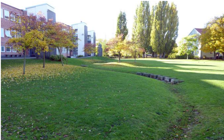
Figur 22. Exempel på utformning av torrdamm. Denna grönyta i anslutning till ett bostadsområde i Malmö fungerar även som överdämningsyta/torr damm. Foto: WRS.
