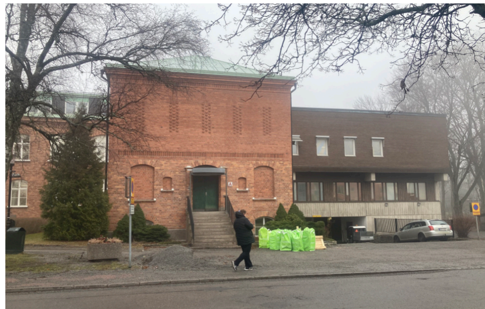
Den ursprungliga lasarettbyggnadens möte med modernismens tillbyggnad.
