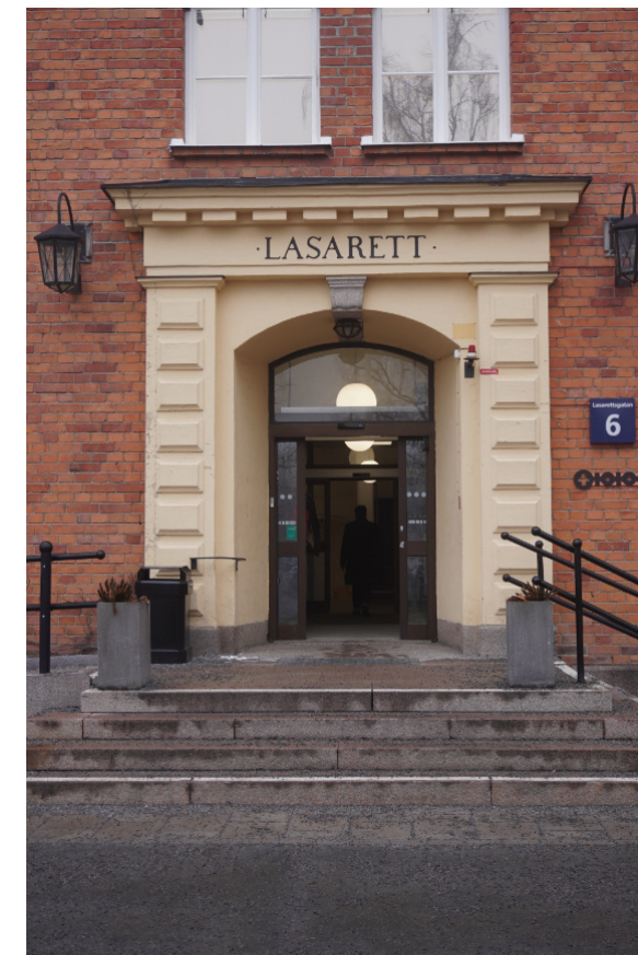
Lasarettets ursprungliga huvudentré med utbytta dörrar (sannolikt av bruneloxerad aluminium), Ovan dörren syns den bevarade funktionen av överljus som förstärker byggnadens karaktär av 1800-tals institutionsbyggnad.
