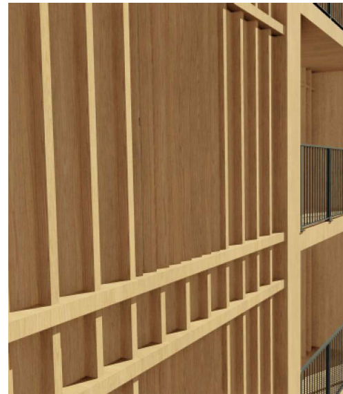
Fönster med ribbor, från gatan
