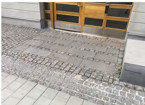
Figur 170. Naturstenshällar som markerar entrén. Bildkälla: Sydväst
