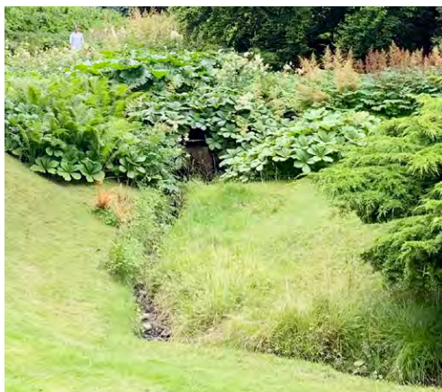
Figur 26. Lokal fördröjning av dagvatten Bildkälla: Sydväst
