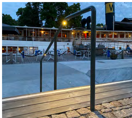
Figur 88. Integrerad belysning i handledare, Planet Lighting/Fox Design - HLS "puck" 60-90°. Bildkälla: Sydväst
