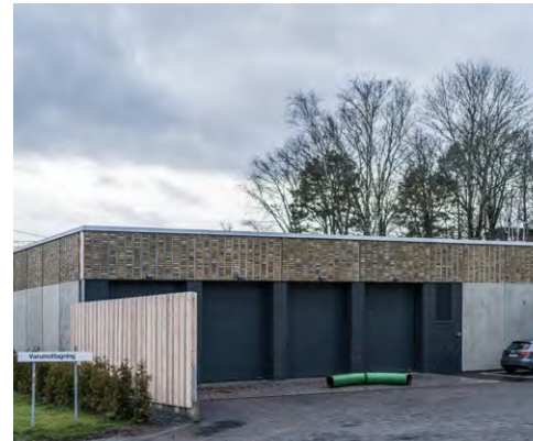
Figur 128. Sopsugscentral vid Roslagens sjukhus. Bildkälla: Norrtälje kommun
