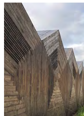
Figur 60. Modern unikt konstruerad träfasad. Bildkälla: Sydväst
