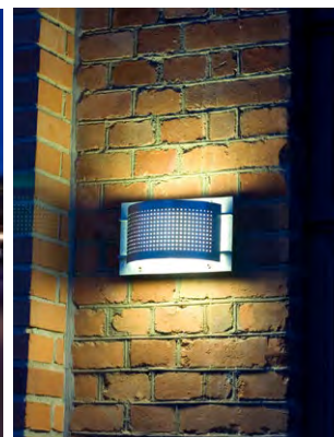
Figur 137. Ej bländande armatur. Bildkälla: Light Bureau (AFRY)
