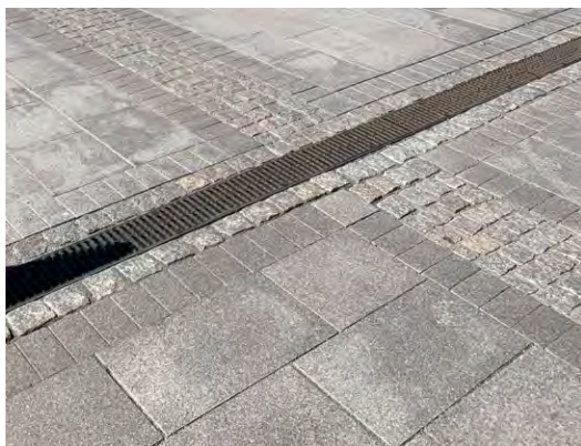
Figur 251. Linjeavvattning Aco-drain. Bildkälla: Sydväst
