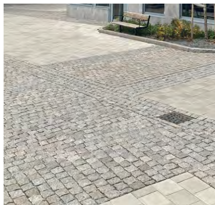
Figur 171. Betongplattor och smågatsten är huvudmaterialen längs gågator och gångfartsområden. Bildkälla: Sydväst
