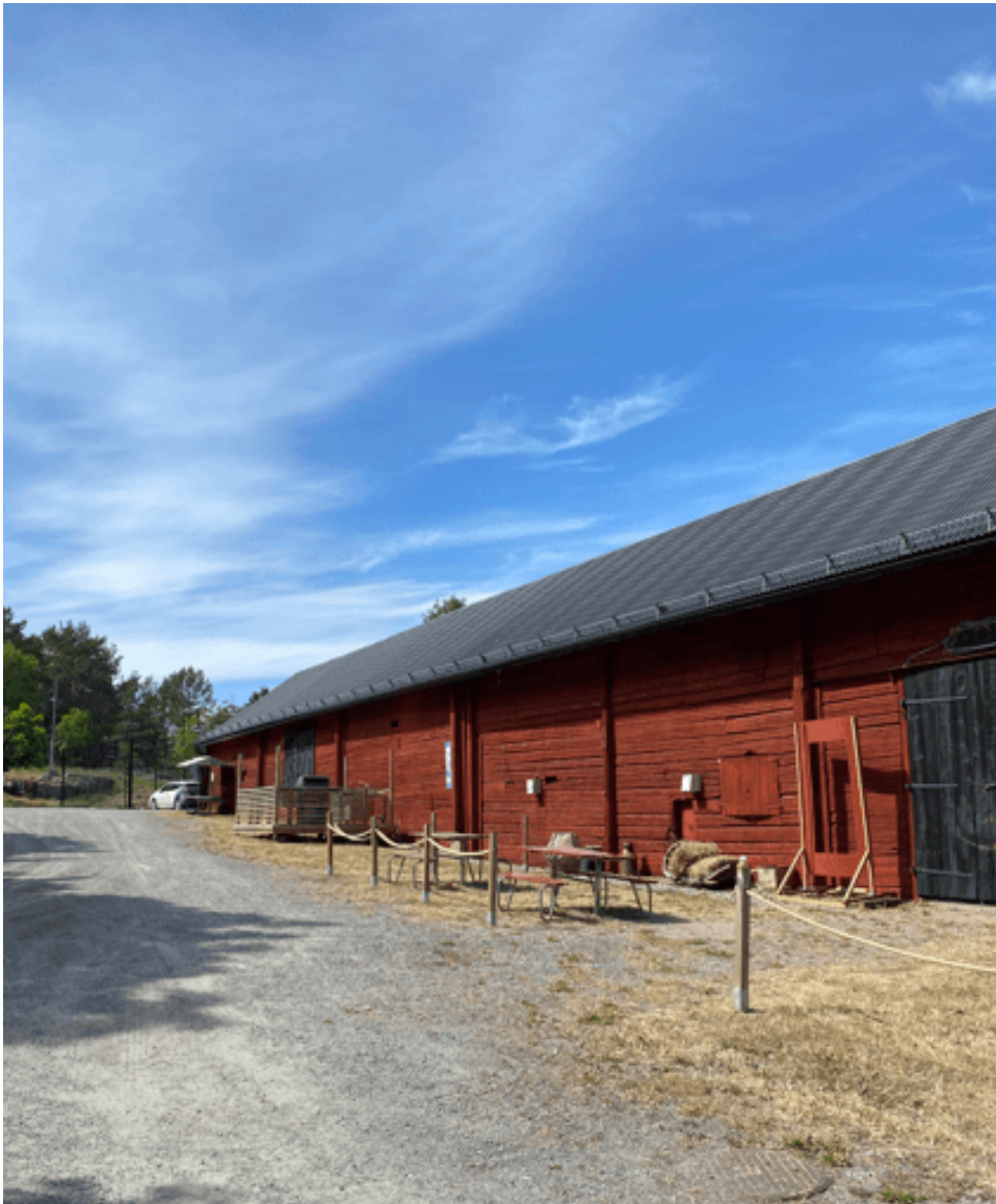
Figur 35: Lidrets södra fasad, vy mot väster. Foto Emelie Hansebo Norrtälje kommun.
