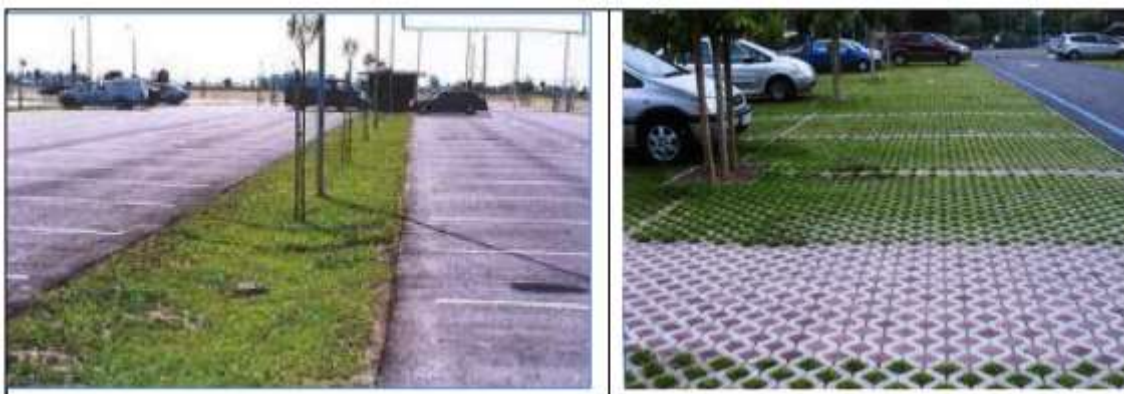
Figur 10. Förslag på avvattningslösningar för parkeringsytor och förslag på parkeringsytor med armerat gräs.
