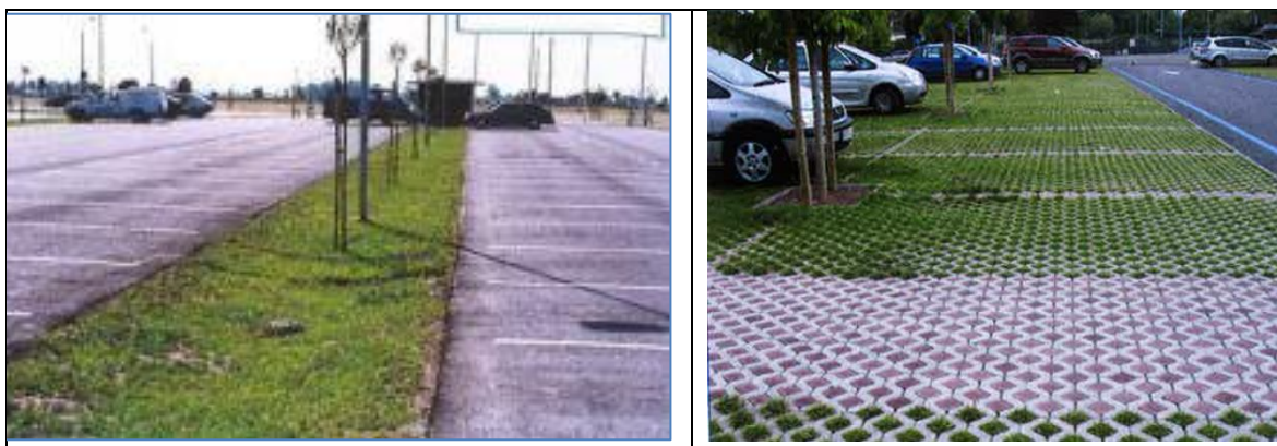
Bild 9. Förslag på avvattning av parkeringsytor och förslag på parkeringsytor med armerat gräs.
