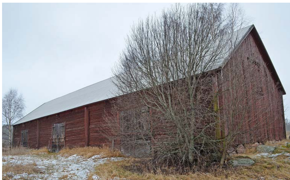
Figur 8. Logen är troligen uppförd under tidigt 1800-tal. Foto mot nordost av Helén Sjökvist.
