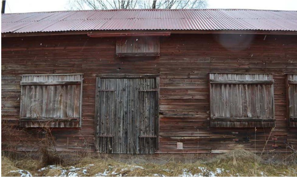
Figur 12. Hönsbus med igenbommade fönster. Foto mot norr av Helén Sjökvist.
