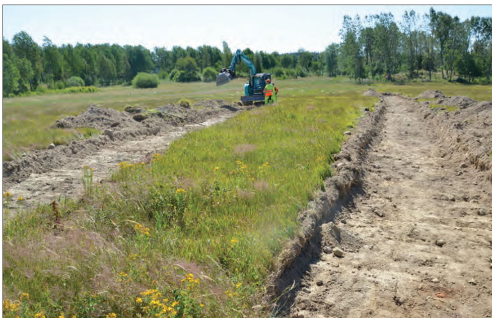
Figur 5. Schaktning pågår i sydöstra delen av Frötuna 226. Schakt 684 till höger i bild, schakt 793 till vänster. Foto från nordväst av Reidar Magnusson..
