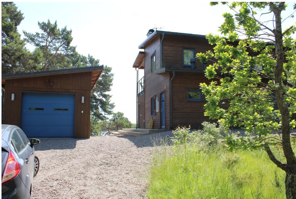
Figur 3 Foto av byggnaden taget från Österskatsvägen.
