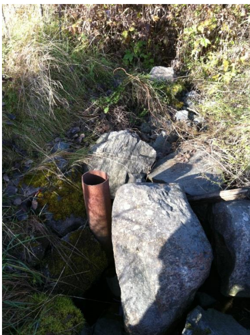
Bild 2. Dike i ovankant av planområde
