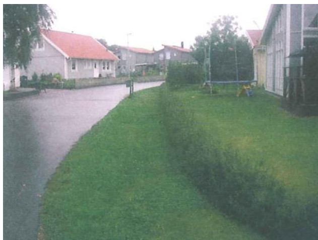
Exempel på avledningsstråk försett med gräs över en grus- och makadamfyllning.
