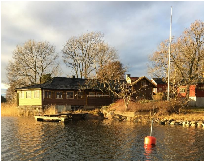
Fastigheten idag, vy mot nordväst. Foto: Norrtälje kommun
