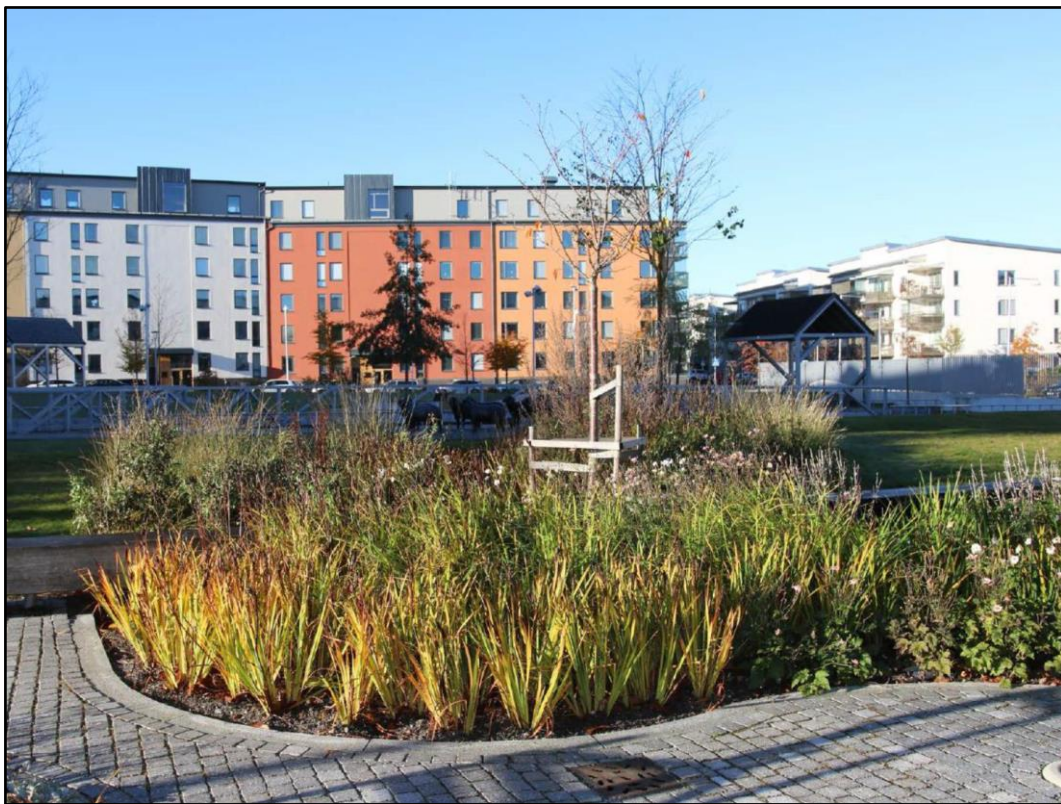
Figur 16 Exempel på nedsänkt växtbädd (Solna stad dagvattenstrategi, 2019).
