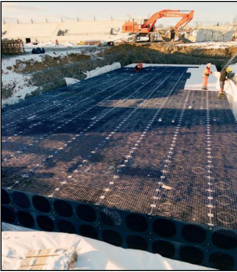
Figur 3 Exempel på utjämningsmagasin i form av dagvattenkassetter. Foto: Wavin
