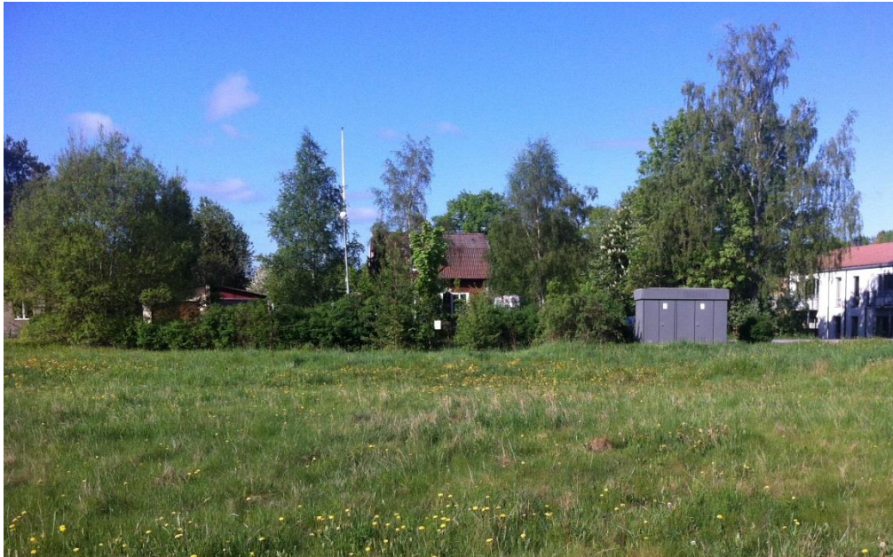
Del av fastigheten 5:91 med befintlig transformatorstation
