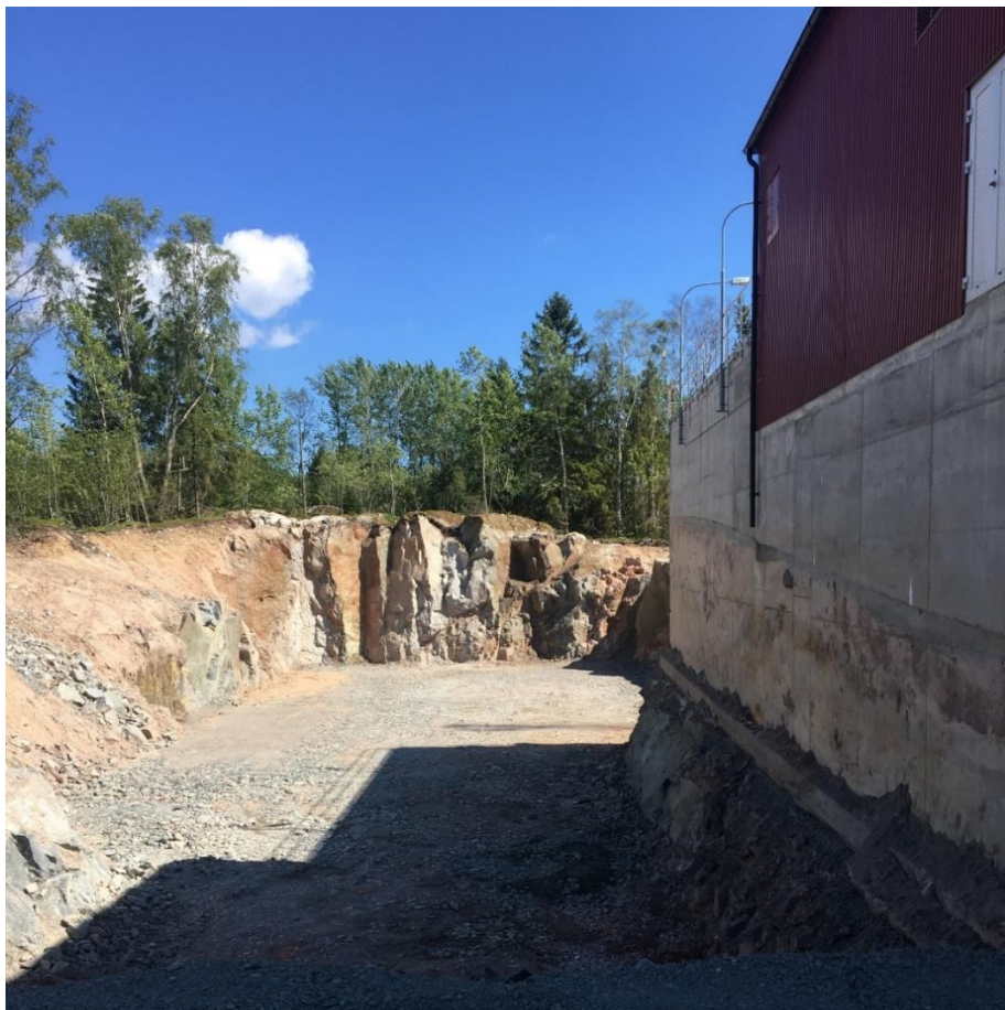
Förberedelse av mark inför utbyggnationen som möjliggör en kapacitet på 15 000 pe, foto: Isabell Eberkvist.
