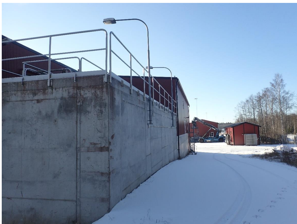
Figur 17 Kapellskärs avloppsreningsverk, bassänger i nordvästra delen.
