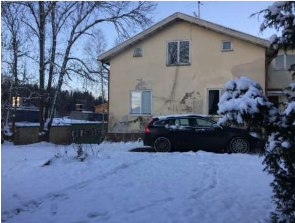
Befintlig byggnad på Orren 1 som ersätts med ett flerbostadshus, foto: Evelina Christoffersson.
