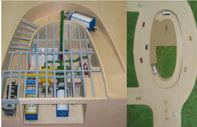
Figur 9 Sopsugterminal under mark, modell Monte del Pilar. (Källa: Envac)
