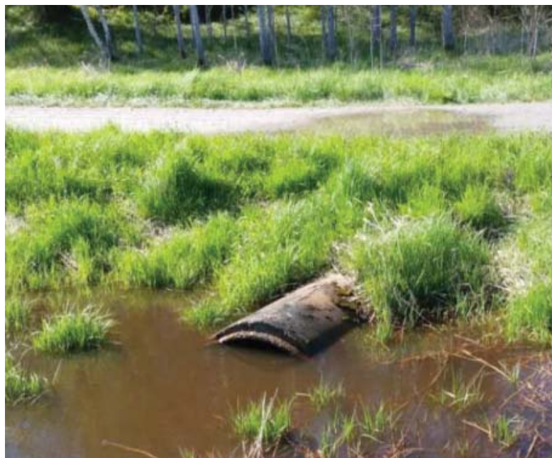
Bild 1. Utlopp från vägtrumma under Kustvägen (länsväg 276). Bild hämtad från ÅF:s dagvattenutredning, Figur 3:53.
