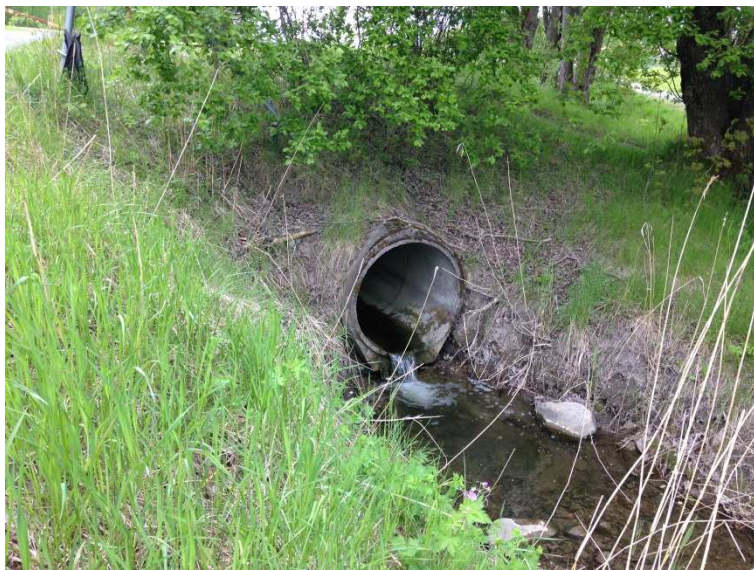
Figur 3:52. Utlopp från vägtrumma under Carl Bondes väg
