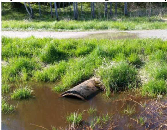
Figur 3:53. Utlopp från vägtrumma under Kustvägen
