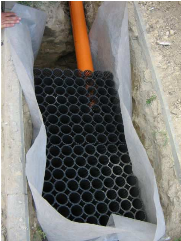
Figur 6:62. Förslag fördröjningsmagasin för dagvatten mot Kyrksjön
