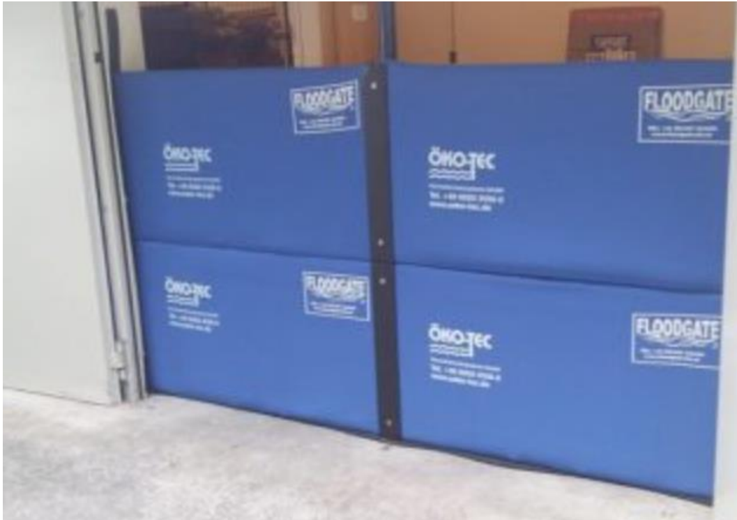
Figur 21 – Exempel på temporärt översvämningsskydd som kräver manuell installation. Källa: https://www.saveco.se/floodgate .
