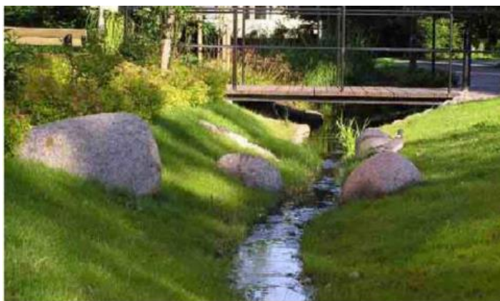
Figur 97 Exempel på svackdike.
