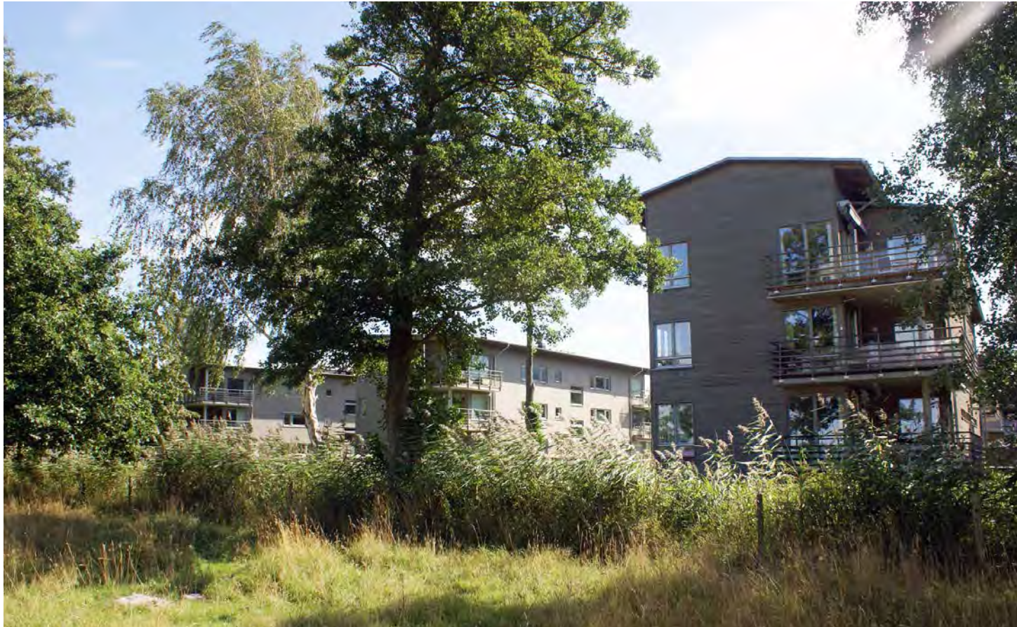
Anpassade byggnadsvolymer i nära relation till landskapet, Opus, Ljunghusen.
