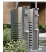
Figur 9: Sopsugsinkast på gård. Källa: Logiwaste AB
