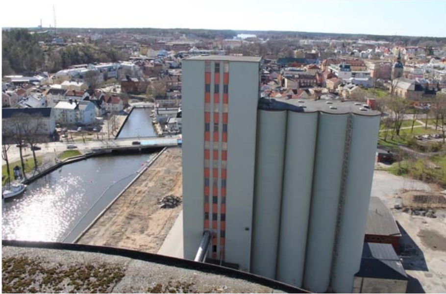
Figur 6. Vy över den tidigare verksamheten i Norrtälje hamn, samtliga byggnader och silos är numera rivna.
