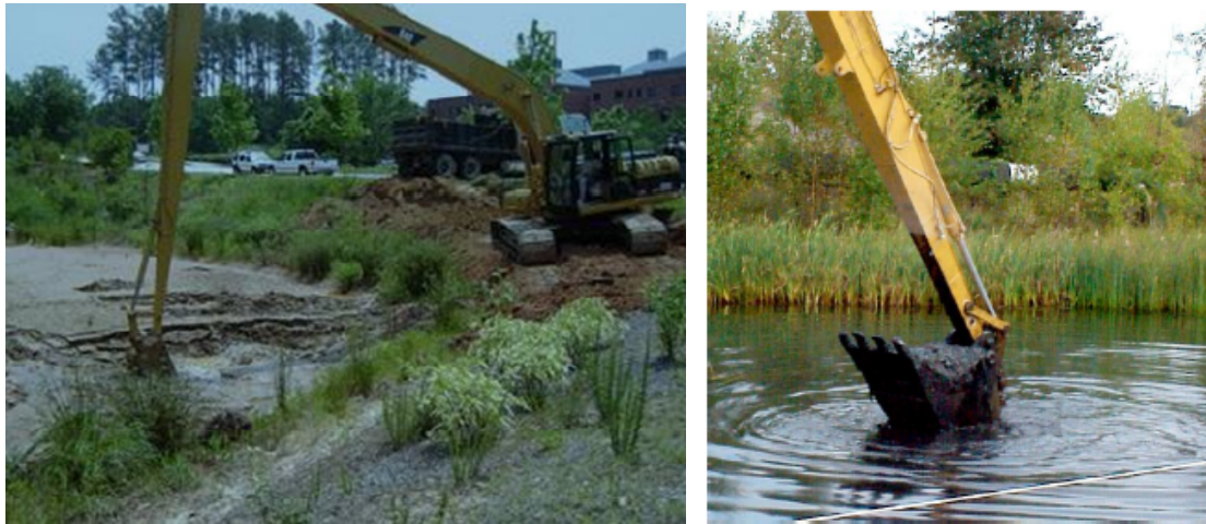
Figur 7. Exempel på en grävmaskin med lång räckvidd som tömmer en damm på sediment. Första bilden från Andersson et al, Skötsel av dagvattendammar – en handbok, 2013. Andra bilden från Trafikverket, Publikation 2015:147 – Öppna vägdagvattenanläggningar.
