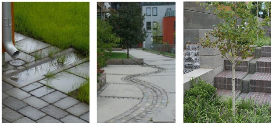
Figur 19. Exempel på utformning av dagvattenrännor i urban miljö. (Exemplet till höger och i mitten är foton från Sweco, exemplet till vänster kommer från S:t Eriks rännalsplattor).
